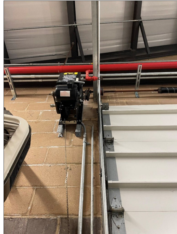
Overhead door motor
